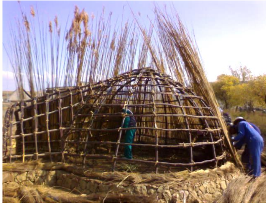
Fig. 117 - 118: Making a Basotho Hut (Khatleli, 2011: 17).
