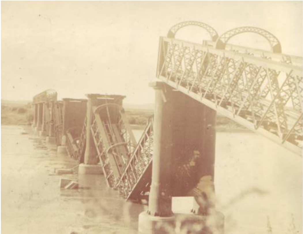
Die beskadigde Bethulie-spoorbrug, gesien vanaf die Kaapkolonie se kant (April 1900). Bron: Oorlogsmuseum van die Boererepublieke, Bloemfontein.
