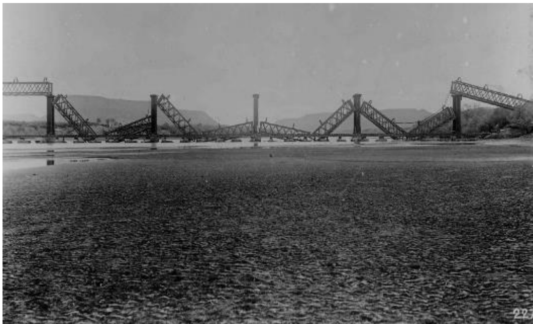
Die beskadigde Bethulie-spoorbrug (April 1900). Bron: Oorlogsmuseum van die Boererepublieke, Bloemfontein.
