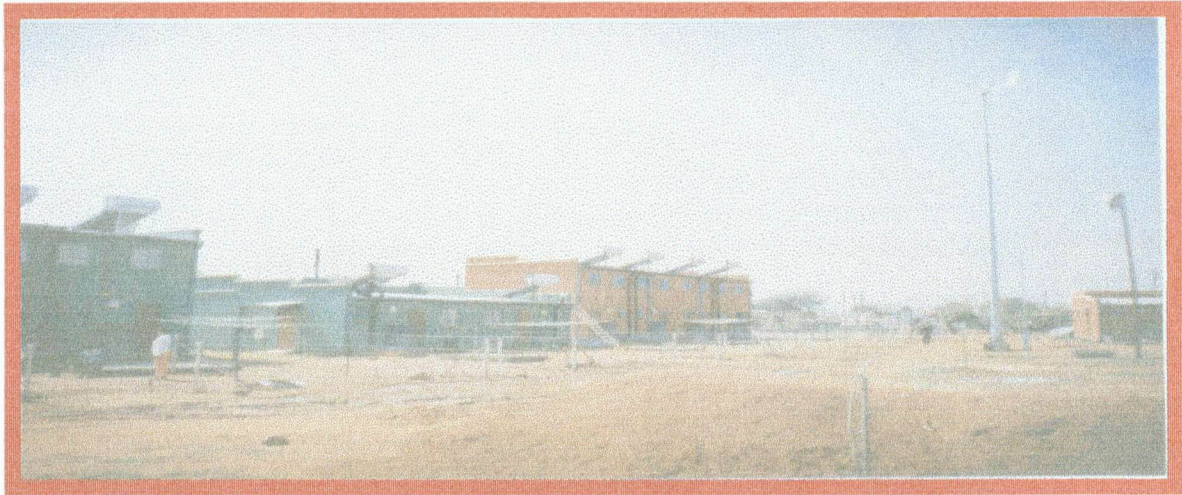
Figuur 4.3: Aansig van die prototipe eko-behuising in Galeshewe. Op die linkerkant kan die sonpanele op die huise se dakke waargeneem word en op regterhand staan die windlaaier.
